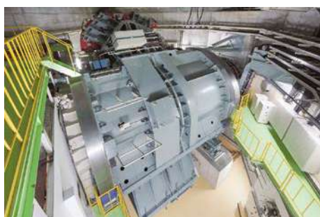
1 階ガントリー照射室 (ガントリー外観 重量200t超)
