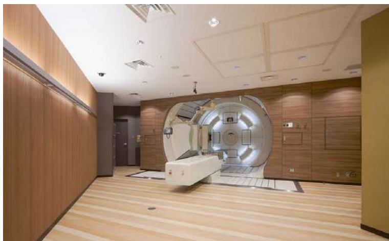
1 階ガントリー照射室
