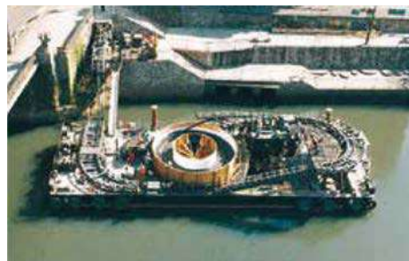
堀川交差部でのケーブル設置工事
