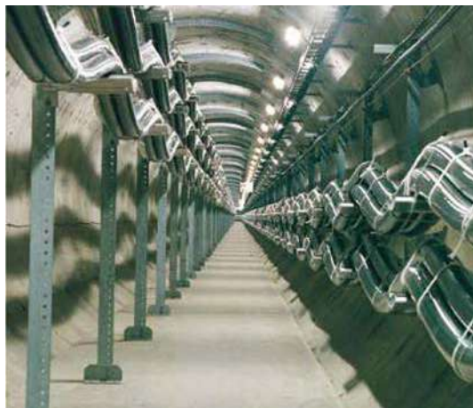
直径4.8メートルの洞道
