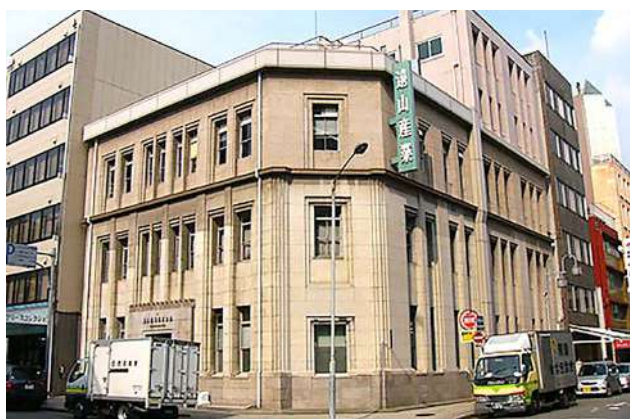
写真2：遠山産業ビル 昭和10年建設 戦後道路拡幅で引きづり工法で移動が話題
